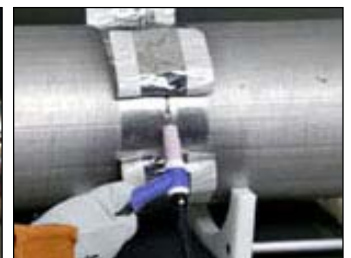
KUN PUTKI ON TÄYNNÄ KAASUA, NIIN ALA HITSATA, JA VETÄÄ TEIPPIÄ HITSIN EDESTÄ
